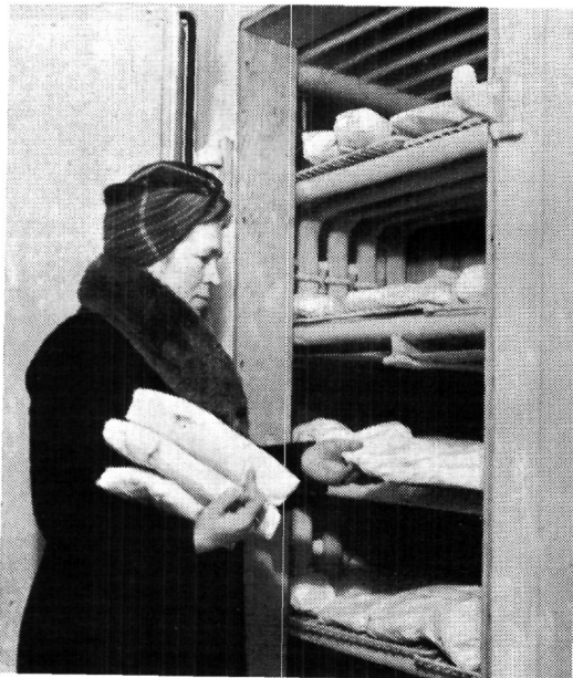
10. Indlægning af varer i dybfryser fra forrummet.
